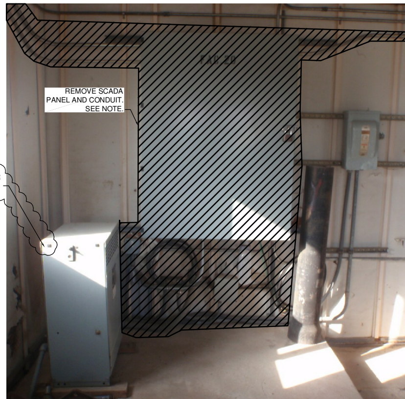
B EXISTING SCADA (PUMP BUILDING) SCALE: N.T.S.
