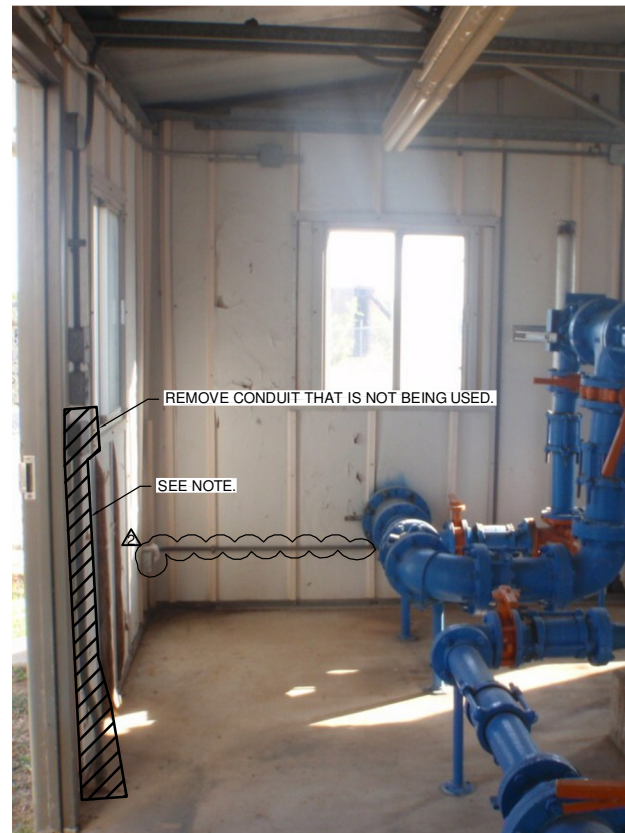
E MISCELLANEOUS OF (PUMP BUILDING) SCALE: N.T.S.
