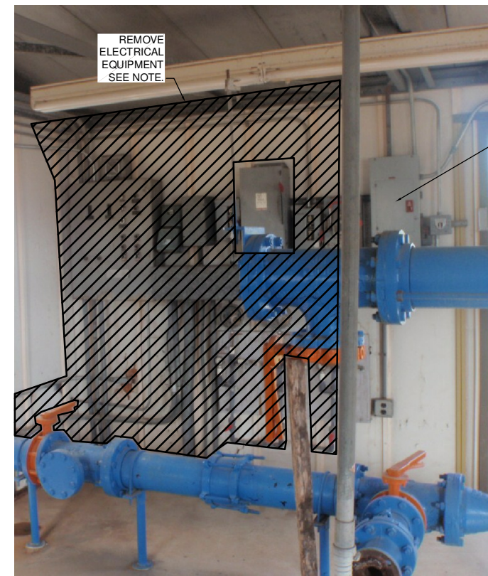
C EXISTING PUMP CONTROLS (PUMP BUILDING) SCALE: N.T.S.
