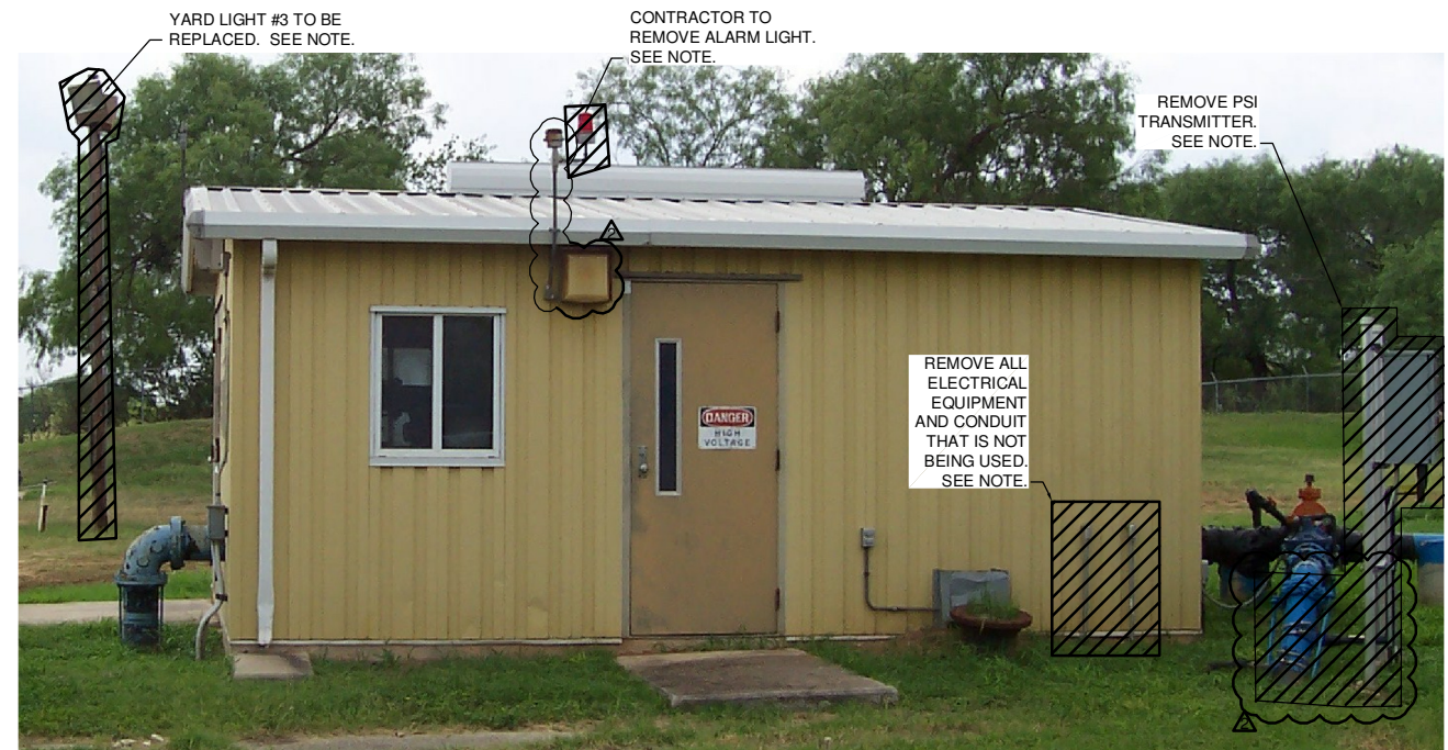
F EXISTING PUMP BUILDING SCALE: N.T.S.
